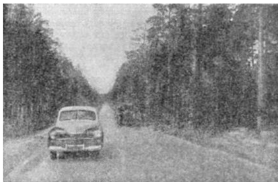
В сложных условиях горнолесистой и песчаной местности построена дорога, связывающая город Куйбышев с районами великой стройки.
